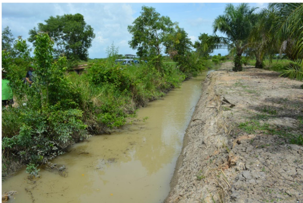
โครงการขุดรื้อและวางท่อระบายน้ำ คสล. ม.๑๓
